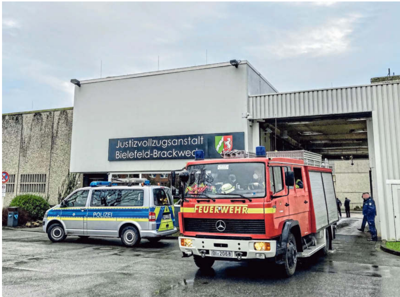
Brennt es in der Justizvollzugsanstalt Brackwede, müssen beide Tore der sogenannten Schleuse offen bleiben. Polizei- und Justizbeamte müssen für die Dauer des Einsatzes den möglichen Fluchtweg bewachen. Im Hafthaus 3 war ein Feuer ausgebrochen. FOTO: JENS REICHENBACH
