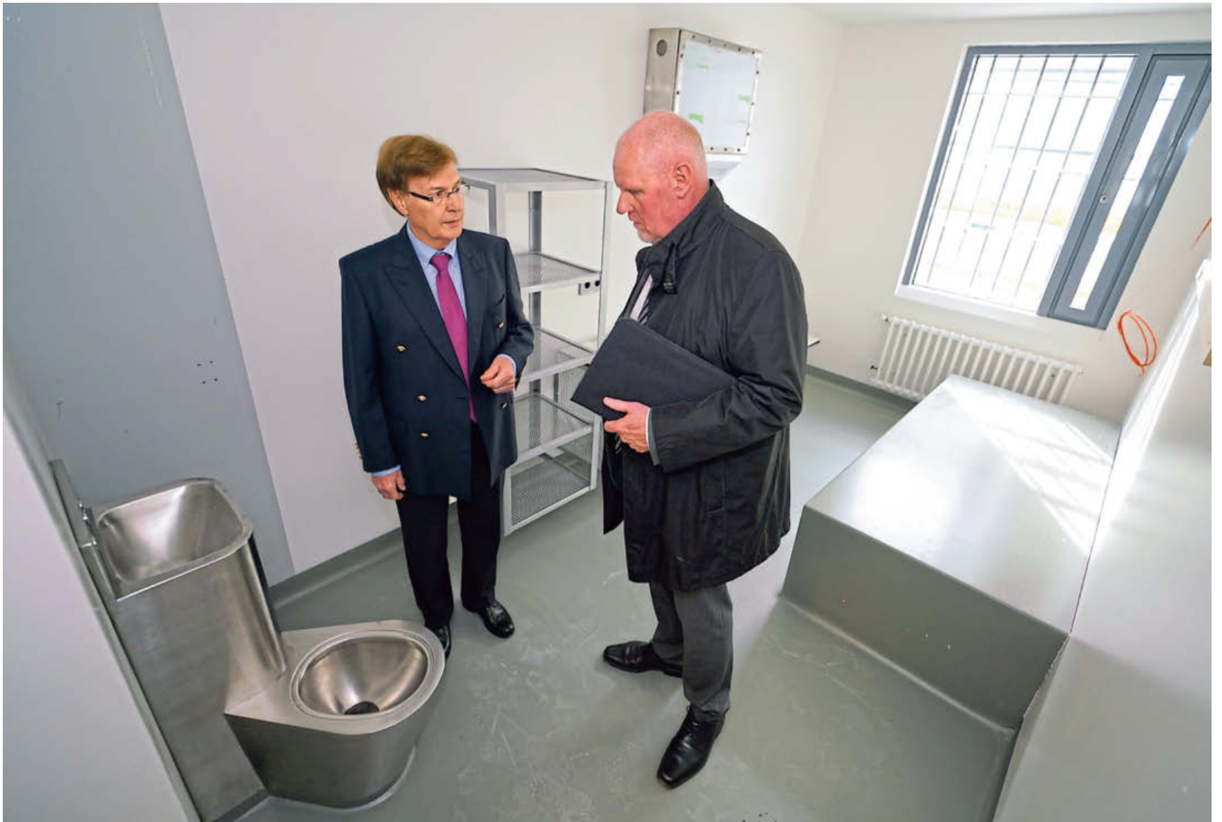
NRW-Justizminister Peter Biesenbach (l.) steht mit Anstaltsleiter Uwe Nelle-Cornelsen in einer Schlichtzelle. In diesen Zellen werden renitente Insassen untergebracht, die ange droht haben, die ganze Zelle auseinanderzunehmen. Hier ist das kaum möglich: Das Bett ist ein Betonklotz, Klo und Waschbecken sind aus einem Guss. Fotos: Peter Unger
