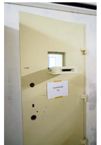
350 Kilo wiegt so eine Stahltür. Das Schließsystem fehlt noch.
