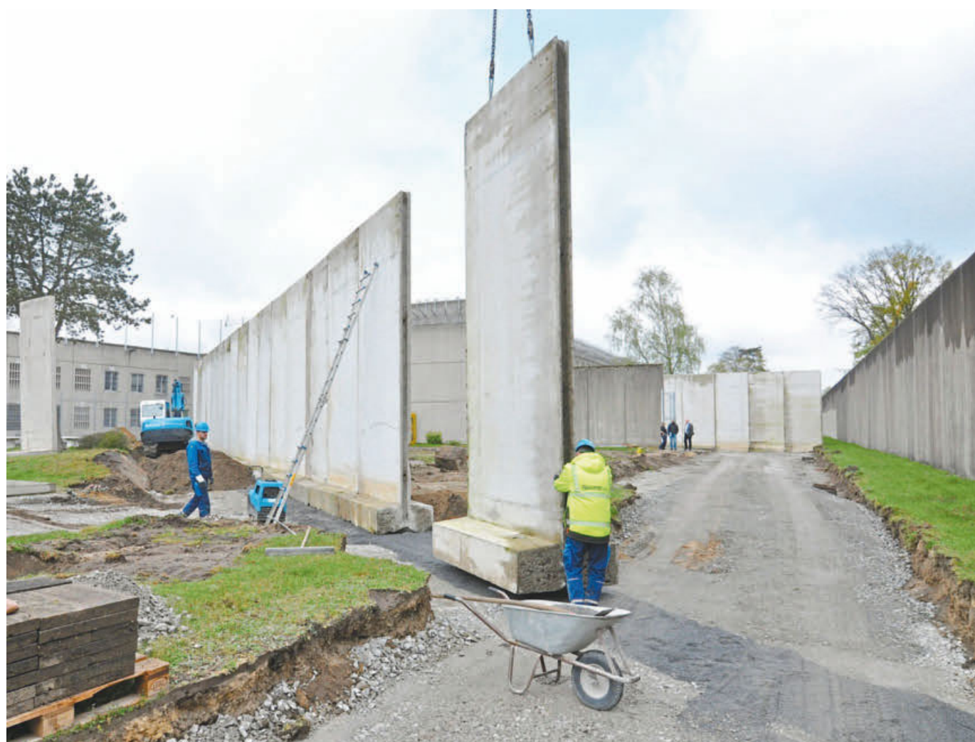
Aus mobilen Betonelementen (Bild, vorne und hinten), die ein Lastenkran anliefert, bauen Handwerker einen Korridor auf dem JVA-Gelände, der es später erlaubt, die alte Gefängnis-Außenmauer (rechts) zu öffnen, ohne dass Fluchtgefahr besteht. Fotos: Markus Poch
